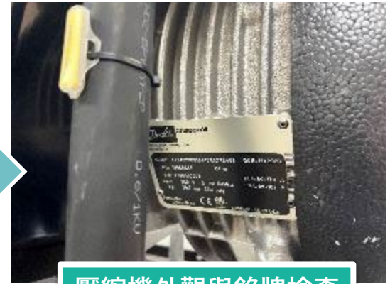
壓縮機外觀與銘牌檢查
