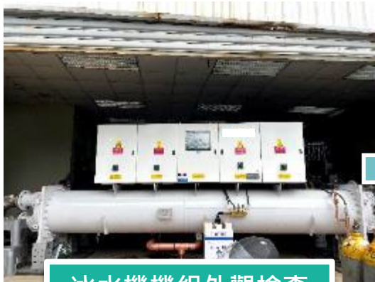
冰水機機組外觀檢查
