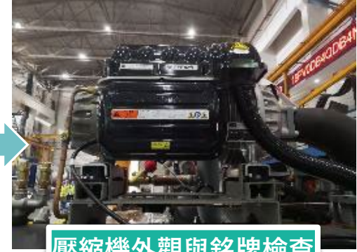
壓縮機外觀與銘牌檢查
